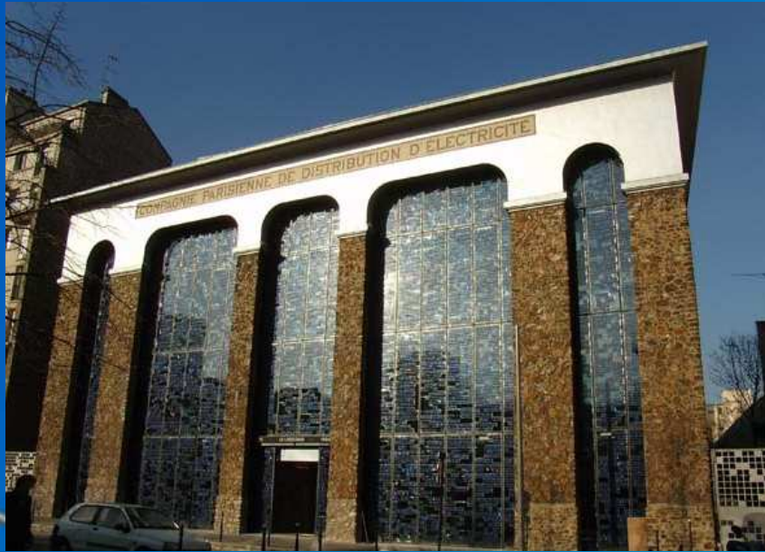
façades photovoltaïques Paris 14e
